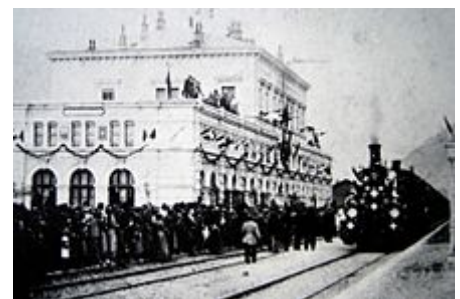
Inauguración en 1882 del Túnel ferroviario de San Gotardo , que conecta al cantón del Tesino en el sur del país
